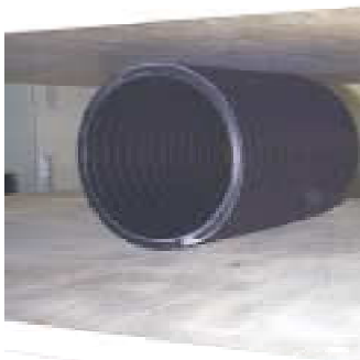
写真3-1.管の設置状態
